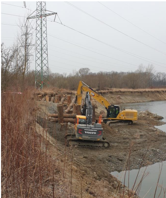
V březnu 2022 byl zpevňován břeh Bečvy v místě, kde se nachází poblíž sloup vysokého napětí.
